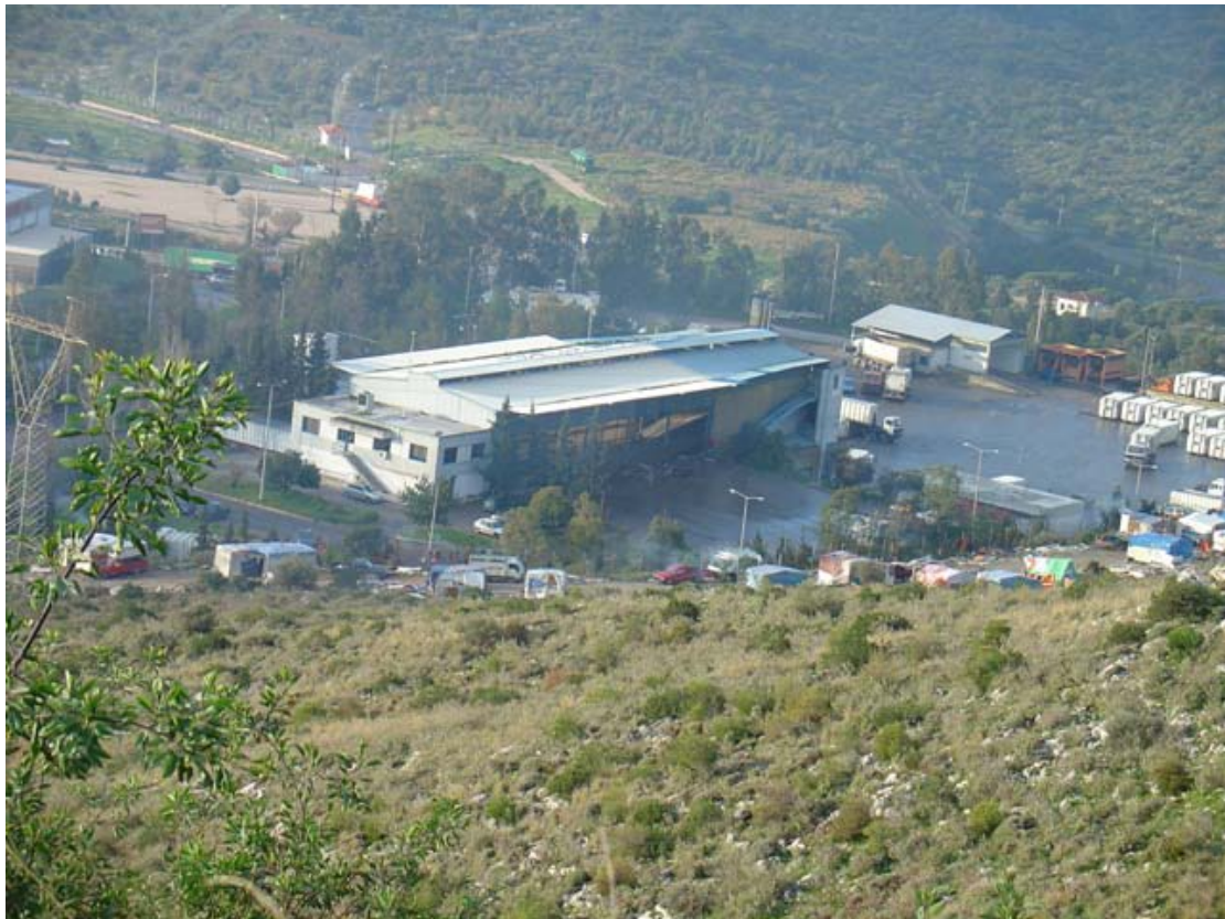
ΣΤΑΘΜΟΣ ΜΕΤΑΦΟΡΤΩΣΗΣ ΑΠΟΡΡΙΜΜΑΤΩΝ
